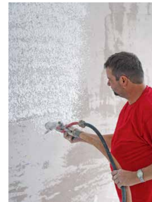
Sämtliche Wände sind mit Knauf Rotkalk verputzt: Der Aufbau mit Rotkalk Grund, Diamant Spritzputz sowie einem Oberputz verhindert Schimmelbildung und schafft ein angenehmes Raumklima.
