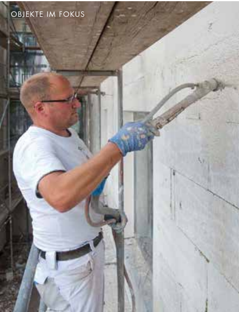
KfW-Standard erreichen die Appartementshäuser in Göttingen u.a. durch das Knauf WARM-WAND WDV-System mit Mineralwolle-Dämmplatten.
